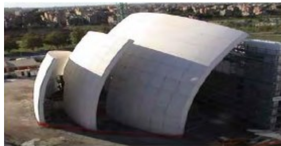
تصویر ۷ نمای کلیسای Dives ساخته شده از بتن خود تمیز شونده (رئیس قاسمی و پرهیزکار، ۱۳۸۸)
